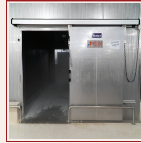
Hầm đông gió: 2 x 4tấn/4h/lần Air-blast room: 2 x 4mt/4h/time
